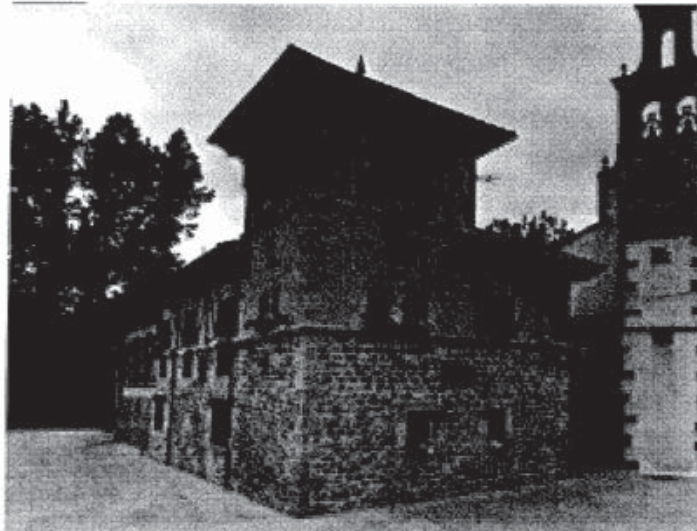
Vista del EQ-2 de Nestares, Casa del Cura; en el que la aprobación inicial del PGOU prima los usos taller e industria frente al actual hostelero-hospedaje
