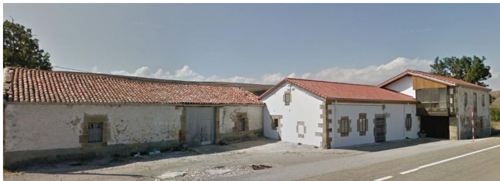
1 Serie de construcciones junto al apeadero ferroviario de Fombellida (Nº 16 del catálogo). Son construcciones de apoyo a la carretera que han ido creciendo sucesivamente y asumiendo el papel de bar de la estación y al servicio de la carretera.
