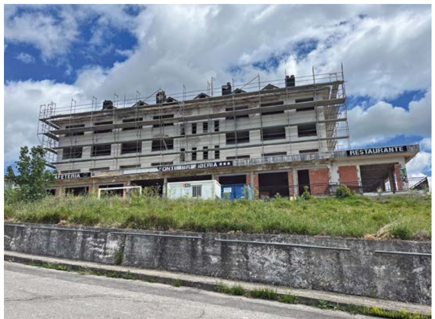
Las obras se ejecutan a buen ritmo
