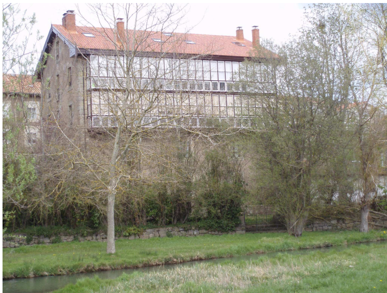
6 Foto edificio zona C. Se percibe como este edificio tradicional se implanta en la zona alta, el sótano no tiene usos vivideros.
