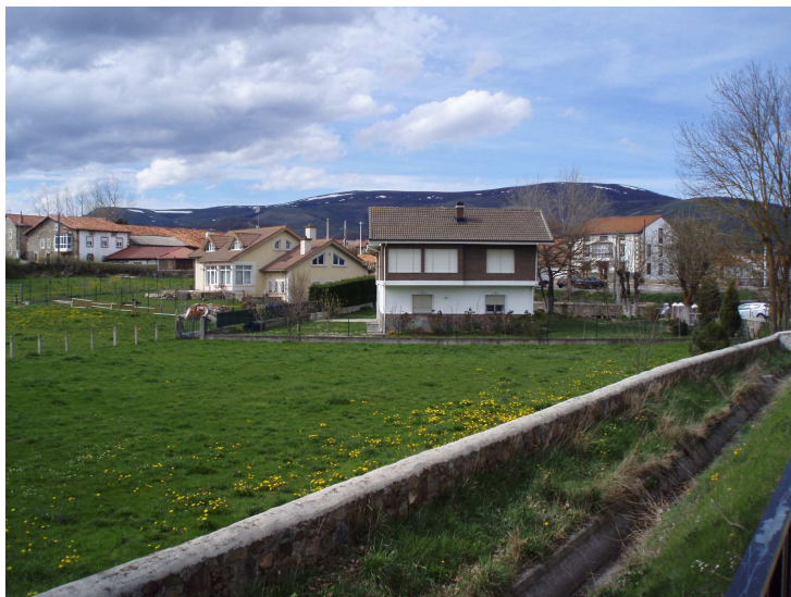
12 Viviendas construidas en la zona más alta de su parcela. Se ve la canaleta del arroyo que transcurre junto a la carretera.
