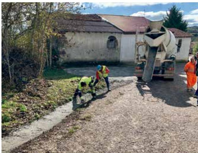
Ejecución de trabajos de recogida de agua pluvial
