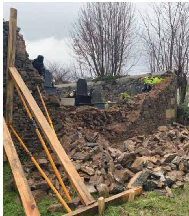
La pared sur del cementerio colapsó por efecto de las lluvias torrenciales
