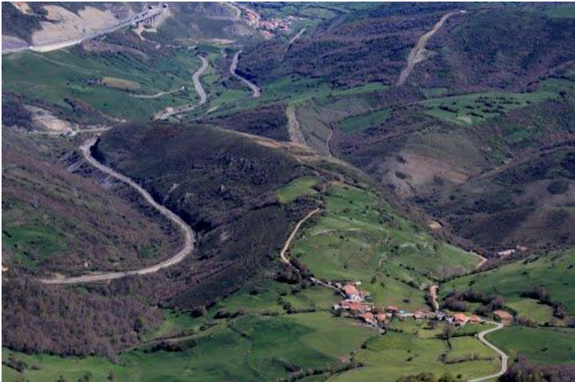
1 El corredor del Besaya. La pequeña aldea de Aldueso. Lomas de prados y zonas de matorral y arbolado. Al oeste las infraestructuras de transporte
