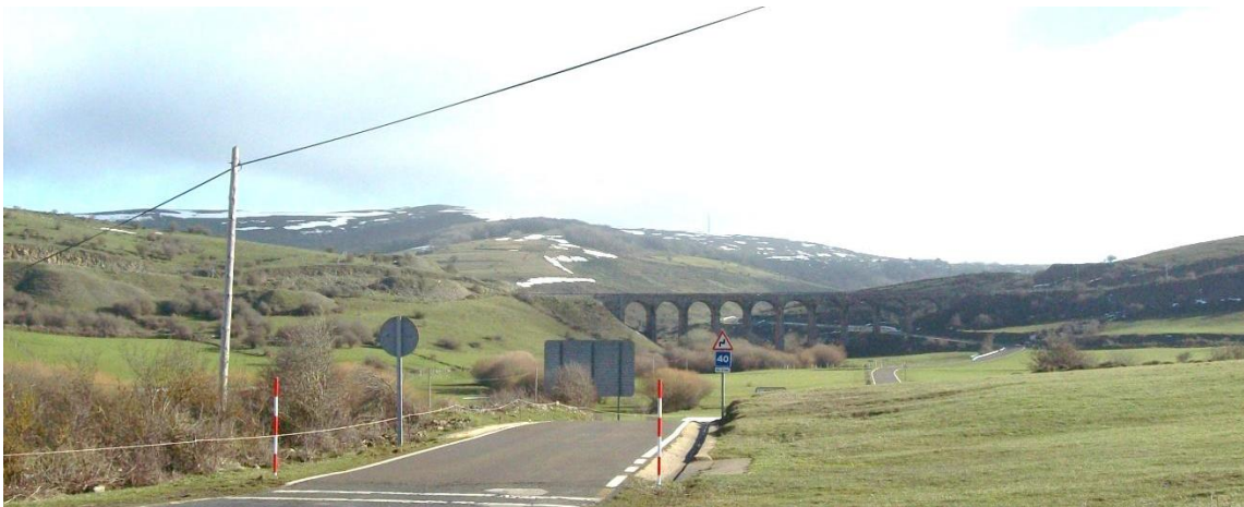
4 Ensanche del valle. El viaducto del FFCC sobre el río Marlantes.
